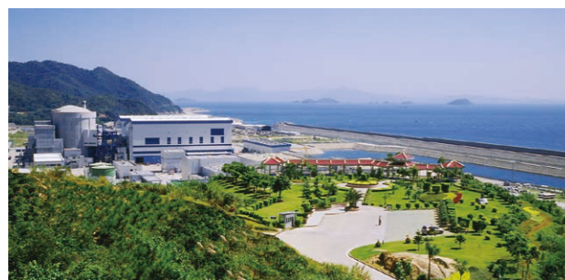
截至 2020 年 12 月 31 日，岭澳核电站 1 号机组连续 15 年无非计划停机停堆，实现连续安全运行达 5291 天，创造了国际同类型机组连续安全运行天数的最高纪录，安全业绩获央视聚焦报道。
