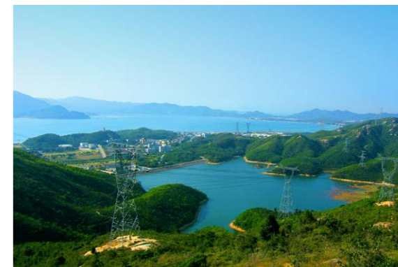
广东大亚湾大坑水库
