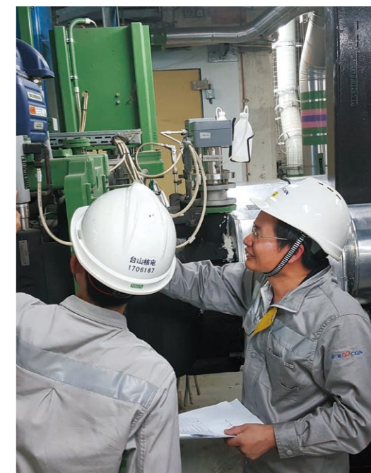
周创彬（右）在核电项目调试现场
