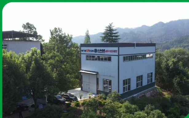
湖北十堰我国首个电子束处理医疗污水示范项目
